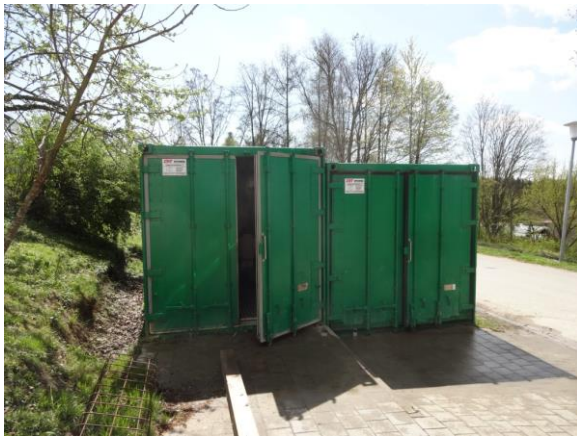
Abbildung 1: beide Kühlcontainer von außen
