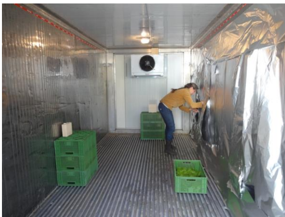
Abbildung 2: Ausstattung des linken Containers mit Aluminiumfolie und Energiekästchen
